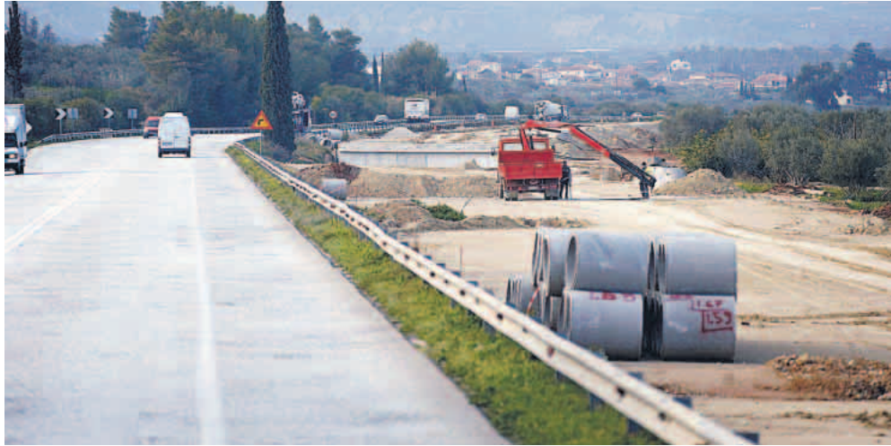
Σύμφωνα με πληροφορίες, πρόκειται για έργα οδοποιίας στην παράκαμψη της Πάτρας
