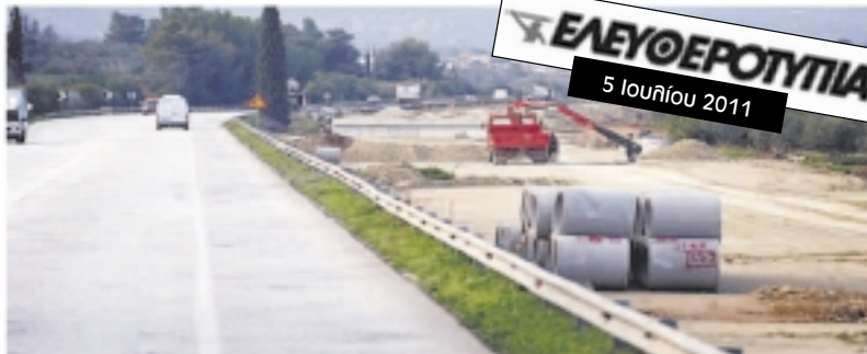
Σύμφωνα με πληροφορίες, πρόκειται για έργα οδοποιίας στην παράκαμψη της Πάτρας
